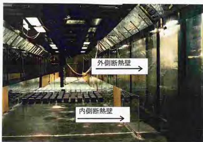
写真 2.1.3 二重断熱壁の設置状況
