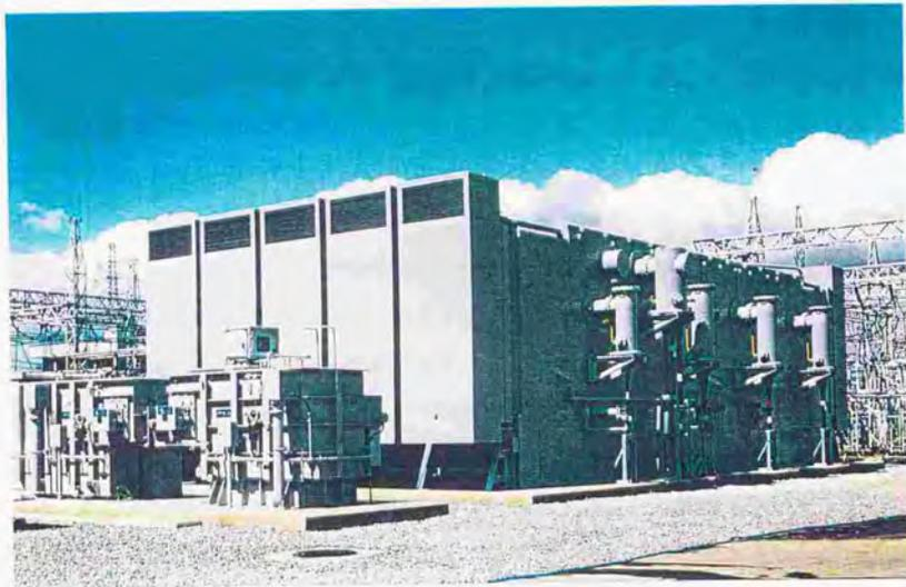
図6.1 154kV, 200MVAガス絶縁変圧器
