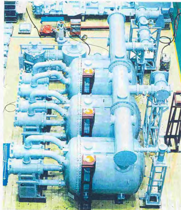
図6.2 275kV, 300MVAガス絶縁変圧器
