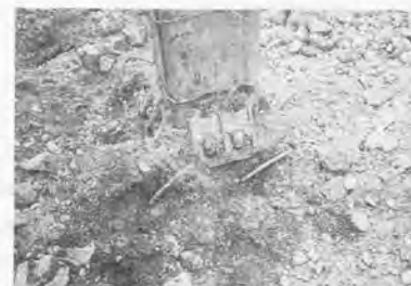
写真5-3 露出柱脚の被害
