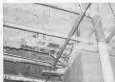
写真5-1 梁端部の破断
