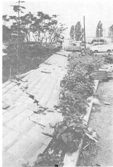
図-49 パロマビル横のブロック塀の倒壊
