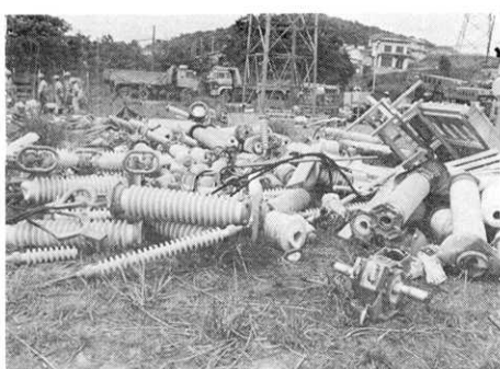
図-35 仙台変電所での折損した碍子
