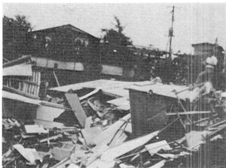
図-47 黒松アパートの被害
