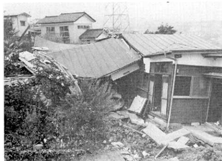
図-45 仙台市緑ヶ丘での地すべりによる住宅の被害
