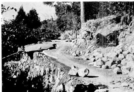
第17図. 道路 および 石垣の破壊, 志津摩川上流 (Loc. 11), 右側の斜面上に地割れが続く.
