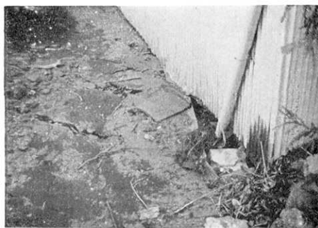
第20図. 志摩津川東岸上のミカン小屋土台の変位 (Loc. 13).
