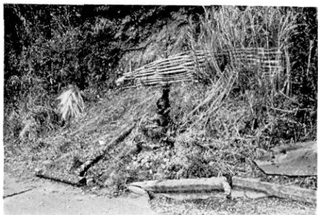
第70図. 浅間山南方, 縁石が右ずれ, 法面の切り取り面上にきれつが続いている (Loc. 37).
