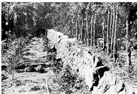
第12図. 石垣の右ずれと切断, 大峰山東麓 (Loc. 7b).
