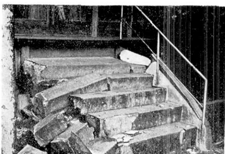
第25図. 稲取入谷, 断層線上の神社の階段の破壊.
