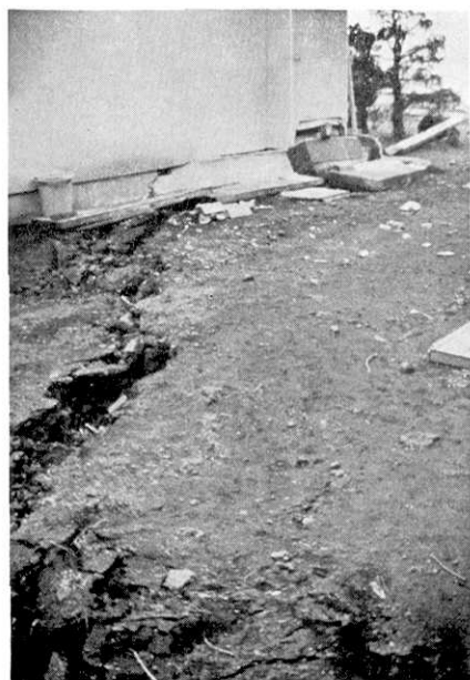
第21図. 断層による家屋の破壊と地割れ, 稲取入谷, 田村豊作氏宅 (Loc. 14).
