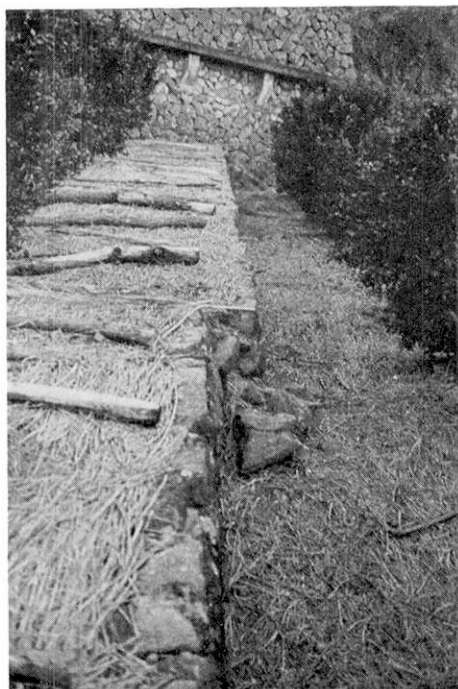
第16図. 石垣の右ずれ, 志津摩川上流, 大峰山東 麓 (Loc. 10).
