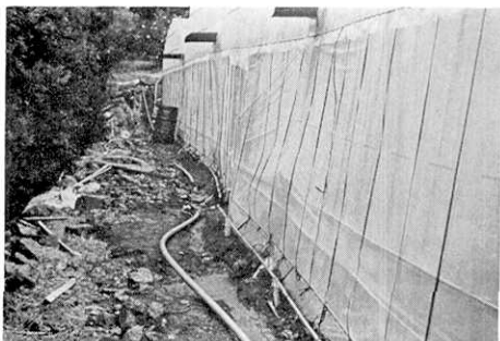
第15図. ビニールハウスおよび石垣の右ずれ, 大峰山東麓 (Loc. 9).
