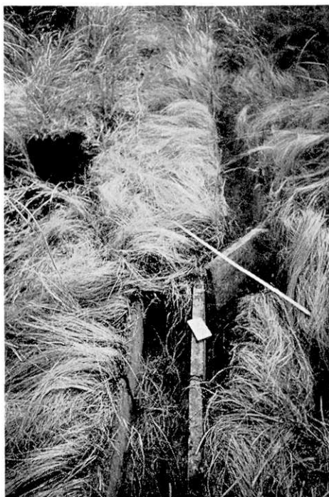
第4図. 側溝の食いちがい, 大峰山東麓 (Loc. 1).
