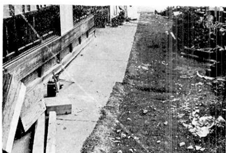
第26図. 稲取入谷, 田村達雄氏宅, 犬走りの右ずれ (Loc. 17a).
