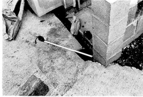
第50図. 稲取西町, ブロック塀の右ずれ移動, 桜井氏宅前 (Loc. 24c).
