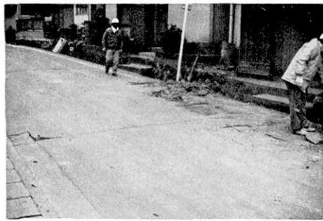
第43図. 稲取水下, 道路を切るきれつ (Loc. 21d).
