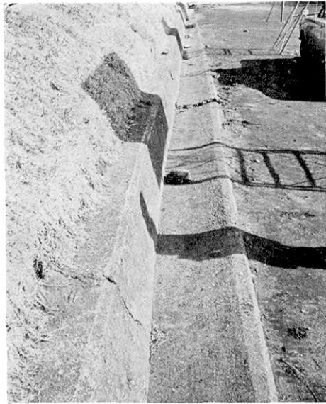
第41図. 稲取水下, 校庭縁石のきれつ, 稲取中学 (Loc. 20c).
