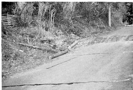
第69図. 浅間山南方の道路のくいちがひ (Loc. 37).
