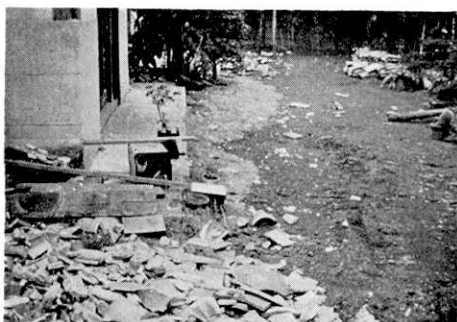
第30図. 稲取入谷, 犬走りの右横ずれと地割れ, 金指滝男氏宅 (Loc. 18c).
