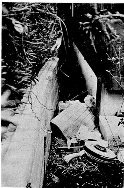
第33図. 稲取入谷, ブロック塀の右ずれ, 垂井正氏宅 (Loc. 19c).
