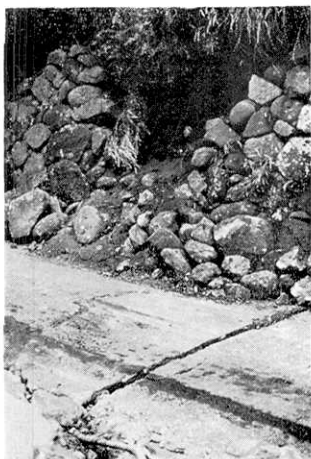
第28図. 稲取入谷, 道路・石垣の破壊 (Loc. 18a).
