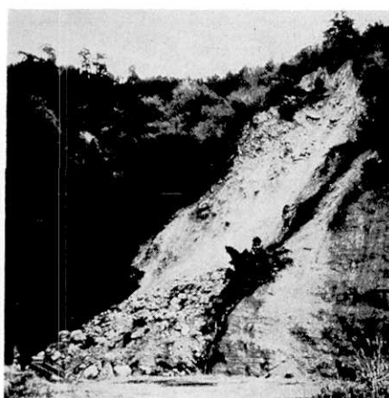
第9図 キャップロック効果による風化層と新期玄武岩の崩壊 (Loc. 14).
