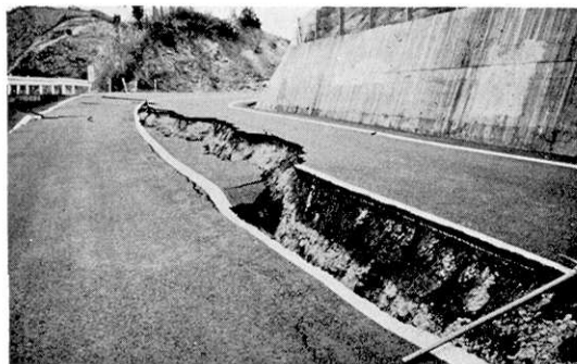
第4図 盛土部分のゆるみによる路面の陥没 (Loc. 20).
