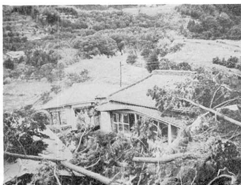
第12図 道路を越えた崩土により押し出された家屋 (Loc. 32)。
