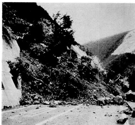
第8図 コンクリート擁壁の上をこえて落下した風化層の崩土 (Loc. 19).
