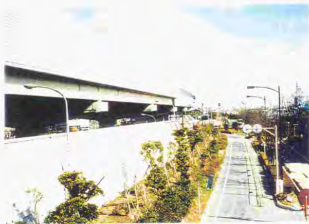
図7.12a 写真7.3(道路は巨大な遮音壁で覆われ、環境施設帯には数々の樹木が植えられている。 右側は側道のサービス道路で、その外側にも植樹帯がある)
