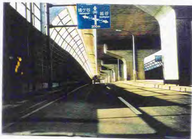
図7.12b 写真7.4(一般国道298号の様子。走路はすっかり遮音壁の中である)
