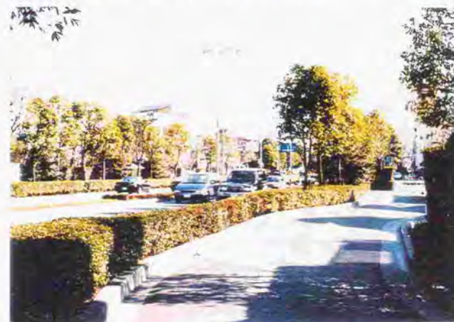
図7.16b 写真7.6: 放射36号線の構造2（幅広い側道が設けられている）
