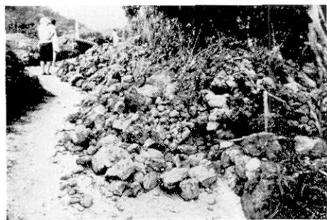
Fig. 16. Collapsed rubblework.
