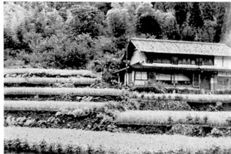
第 12 図 和良村下土京における水田用 石垣の崩壊.
