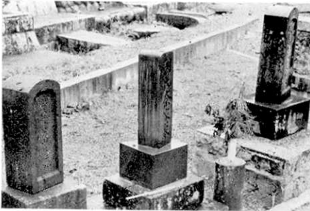
第 7 図 八幡町(慈恩寺)の墓地。 いずれの墓石も左回転しているが転倒はしていない
