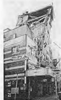
図 1.1: 倒壊を免れた被害建物の例
