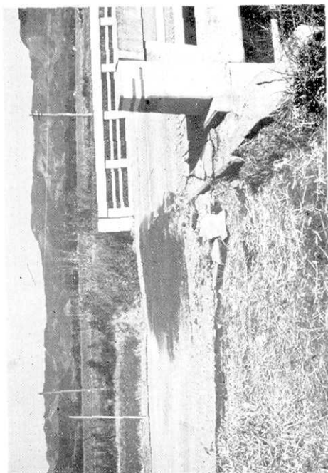
第 22 図 橋は沈下量が少いたため、接合部に生じた喰いちが い。
