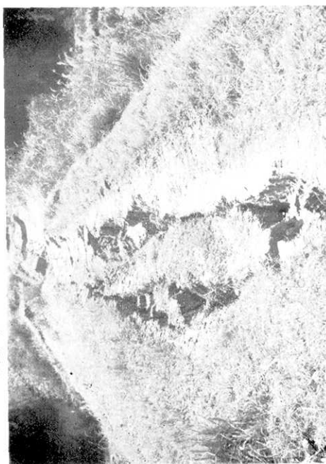
第 21 図 京町南西方の国道の被害。この附近は盛土により 道路が高くなつてゐるので、地震動によりはば伸長 方向に割れ目を生じ全体が沈下した。
