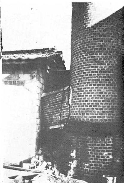
Fig. 33. れんが造煙突の被害 (京町)
