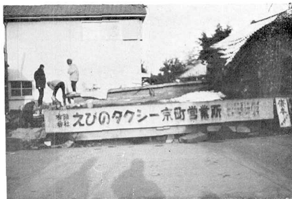
Fig. 30. 倒壊したブロック造 (京町)
