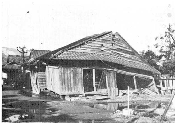
Fig. 6. 第2回目の地震後における倒壊寸前の木造住家、 第3回目の地震で完全に倒れた (京町)
