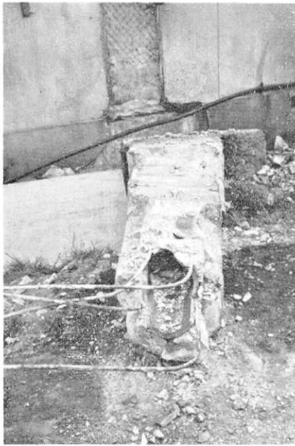
第 28 図 建物の内側にある集合煙突。 (三石)：三石役場提供
