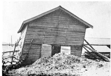
第 15 図 家畜小屋の大傾斜。(三石)： 三石役場提供
