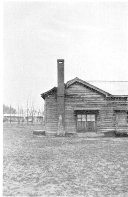
第三十一図 建物の外側にある集合煙突。(静内)
