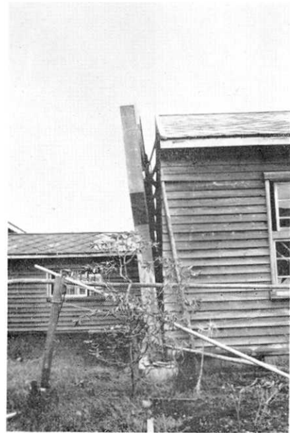
第十三図 側壁の完全分離。(様似) 様似役場提供
