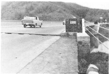
第 40 図 国道 235 号線, 布辻橋の亀裂. (静内): 静内役場提供
