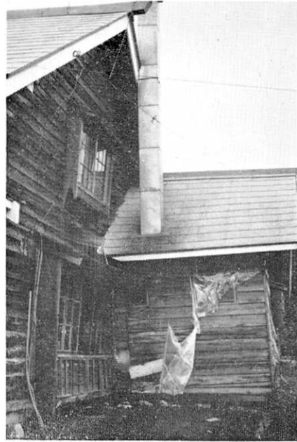
第十一図 土台破損して屋根がねじれる。(富良野)
