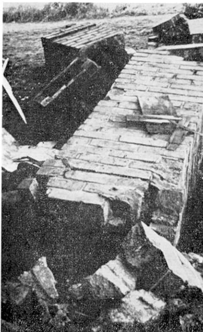
第三十二図 倒壊した集合煙突。レンガ造。(長沼)
