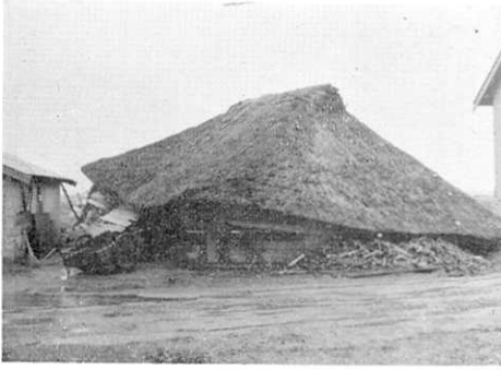
第 10 図 草葺き家屋の全壊。(鶴川)
