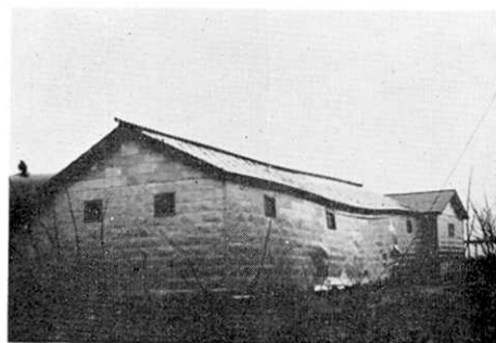
第 39 図 農協倉庫、米俵の押し出しによる。 (門別)
