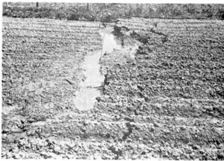
第 54 図 水田地帯の地割れと沈下。(長沼): 長沼役場提供
