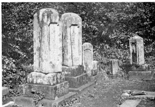
第9図 一斉に右回りに回転した盛岡市における南部家の巨大な墓石群 (左より二番目の墓石に立かけられたスケールは1m).
