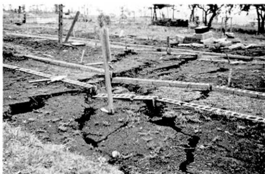
b) 概して南西側(右側)沈下.
