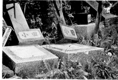
b) 台石が竿石をのせたまま移動し一しよに転落した(八戸市張田).
