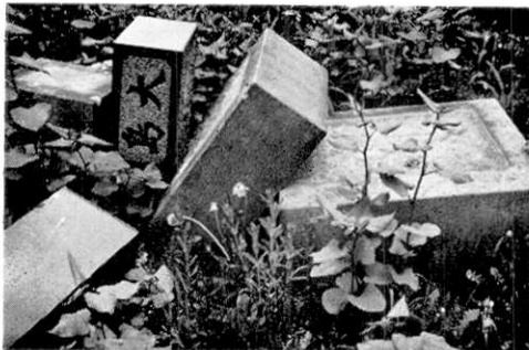
e) 台石の転倒が、その滑動による転落で生じたことを示す(八戸市張田).
