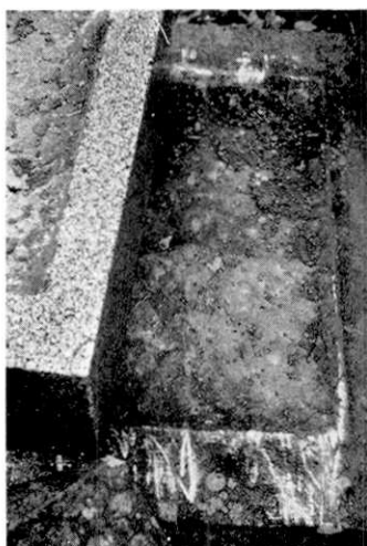
a) 台石は N40^{\circ} \sim 50^{\circ} W 方向に強い条線をつくりながら数回往復し最終的には N40^{\circ} E 方向で静止した (八戸市豊崎町永福寺).
