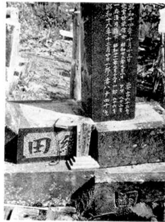
d) はじめ左にあつた竿石は転倒せずに隣(右)の墓の台石の上に移動した(南郷村砂籠).
