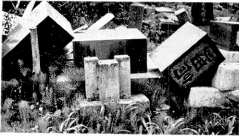
a) 竿石(左)が転倒した後台石(右)がその反対方向に移動し転落した(名川町青鹿長根).
