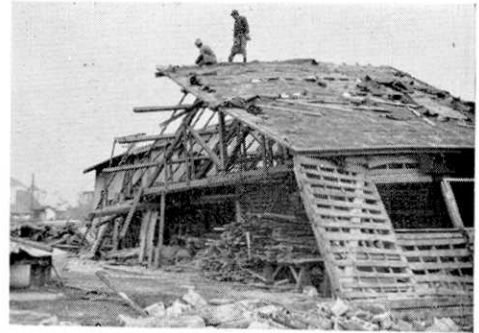
Fig. 11. 一部倒壊した製材所の木造建物 (十和田市)
