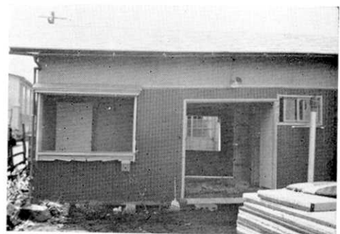
Fig. 15. 基礎が水平にずれた木造住家 (十和田市)
