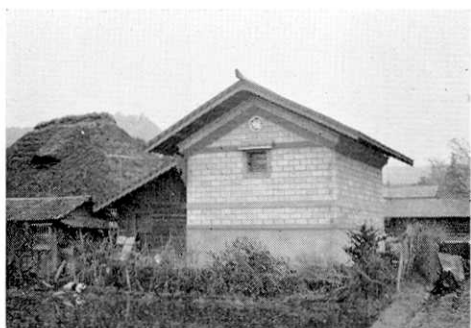
Fig. 48. 被害激じん地区で無被害だつたコ ンクリートブロック造倉庫 (五戸 町志戸岸)
