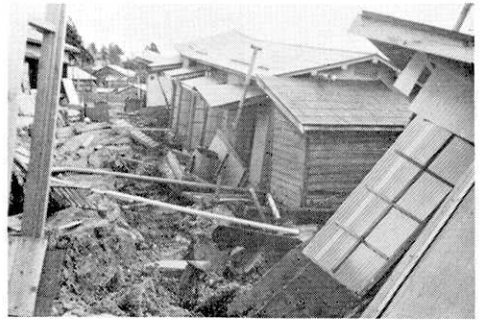
Fig. 23. 地すべりのため倒壊した宅地造成地域の住家群 (むつ市)
