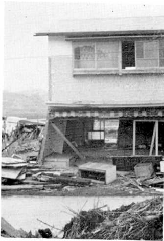
Fig. 10. 1階が大傾斜した木造 2階建店舗 (五戸町志戸岸)
