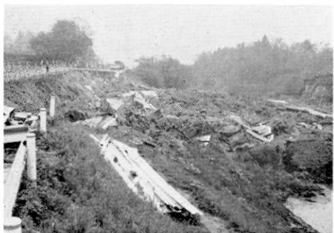
Fig. 50. 道路のすべりによる被害 (国道4 号線)
