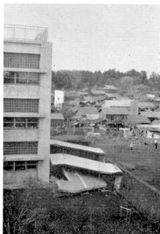
Fig. 37. 鉄筋コンクリート造避難階段の倒壊 (岡三沢小学校)
