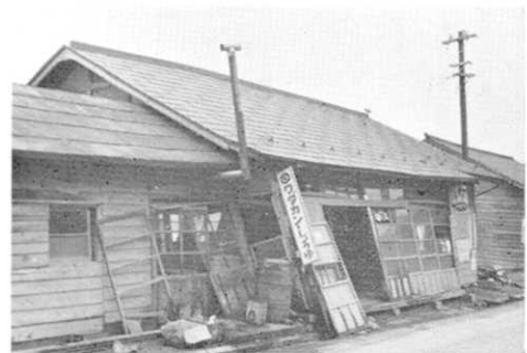
Fig. 9. 大傾斜した木造住家 (五戸町志戸岸)
