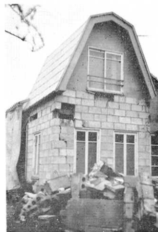
Fig. 45. コンクリートブロック造の被害 (1) (十和田市)
