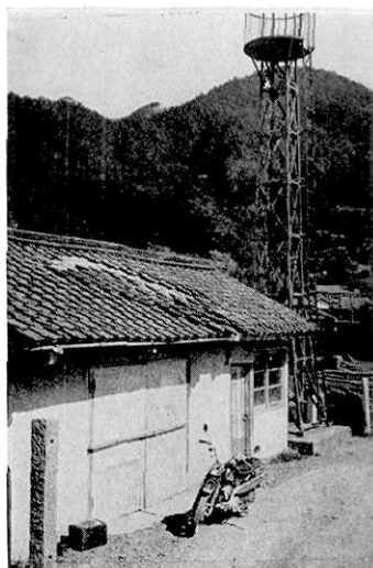
第 23 図 屋根瓦の被害 (愛媛県三瓶町) (三瓶町役場提供)
