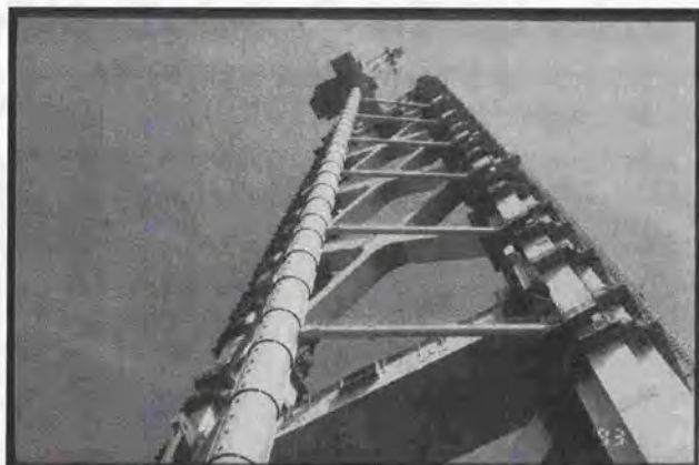
写真 4.2 明石海峡大橋主塔の建設（本州四国連絡橋公団提供） （全ての接合部に設置された足場）
