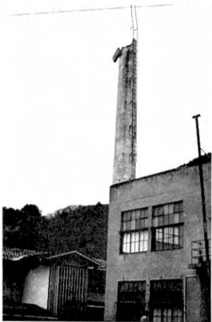
図 16. 長野市街地：西部中学校煙突の折損。（Ⅱ）の被害。
