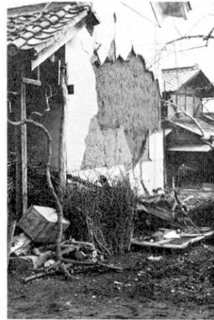
図 7. 若穂清水地区: 土蔵の壁のはくり. (III)の被害.
