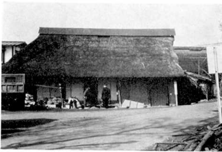
図 4. 須坂米持地区: 傾いた農家 (4° 程度傾いていたが, 更に 1° 程度傾いた. この後すぐ取り壊し). (I)の被害.
