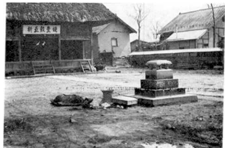
図 8. 須坂相之島地区: 灯ろうの倒壊. (II)の被害.
