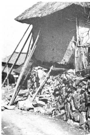
図 11. 若穂山新田地区: がけ崩れによる家屋の被害、(VI)の被害。
