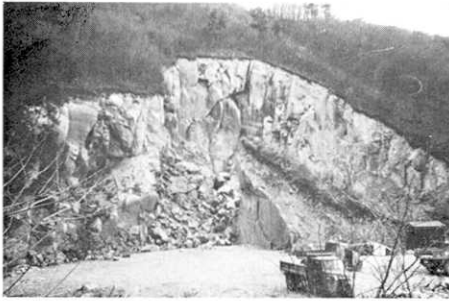
図 21. 松代柴地区：石切場の落石。(II)の被害。
