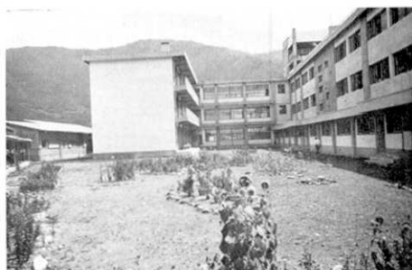
図 30. 戸倉上山田: 上山田中学校, 校舎と渡り廊下.
