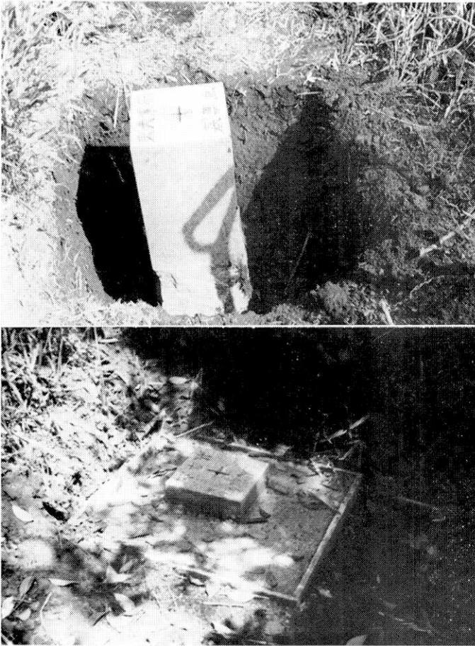
第4図 標石埋設状況
