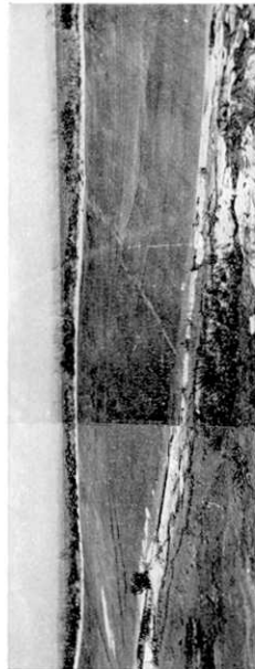
Fig. 15 西部承水路堤の交叉沈下 (WC13 + 400 ~ 600 付近) 亀裂が交叉しその前後で沈下の条が向をかえその間に狭まれた部分は側方へ押出されている。これから堤防の進行方向に圧縮応力が作用したと推定される。
