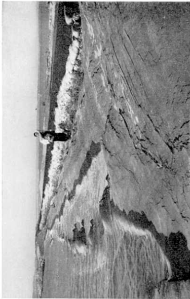
Fig. 14 西部承水路堤の最大沈下箇所 (WC 13 + 200 付近) 最大沈下量は 1.7 m に達した。土俵は応急措置して積上げられたもの。
