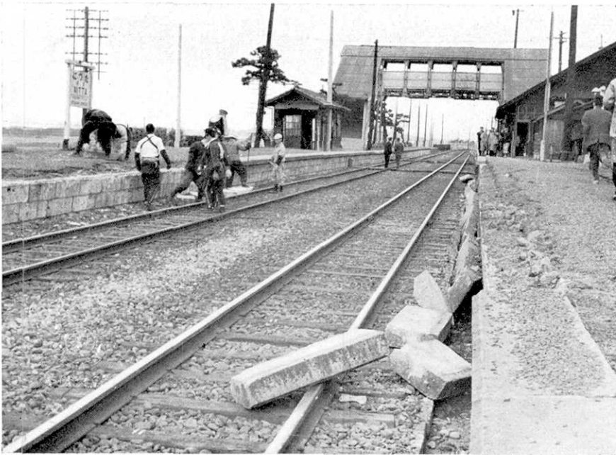
東北本線新田駅プラットホームの笠石の崩落
