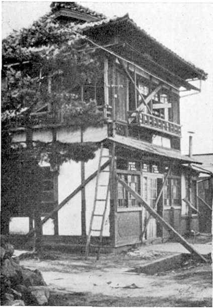
第 2 図 基礎部分にずれが生じ上部も被害をうけた (田尻町田尻)
