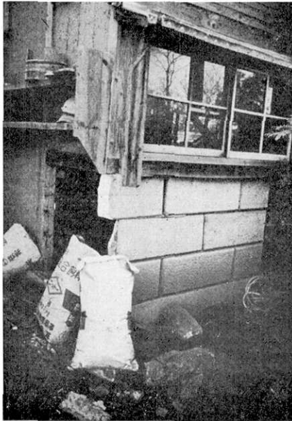
第 8 図 住家台町の石積み部分の被害 (南方村一の曲)
