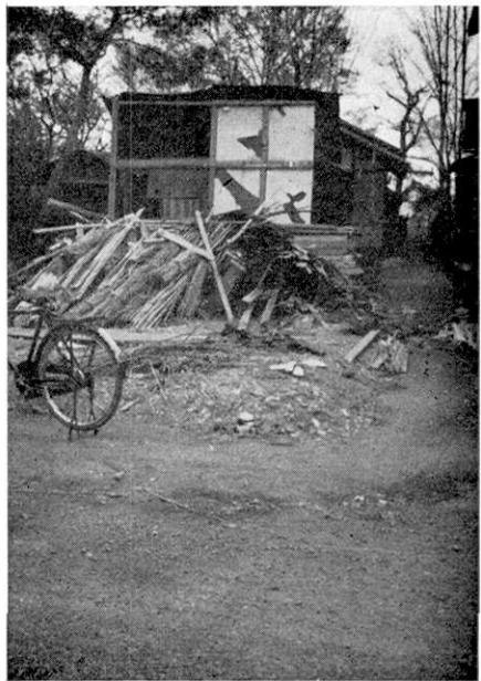
第 20 図 店舗住宅の店舗部分が倒壊した (若柳町大林)
