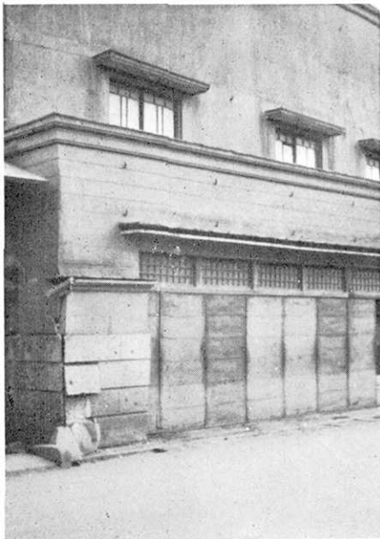
第 4 図 木骨石ばりの店舗の被害 (田尻町田尻)
