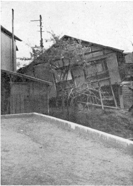
第 17 図 第 18 図の家と同様 1 階が倒壊した (若柳町石の森)
