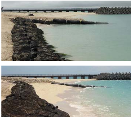
図-1 サンドパック突堤上手の土砂堆積 (上：2011年3月、下：2011年6月)
