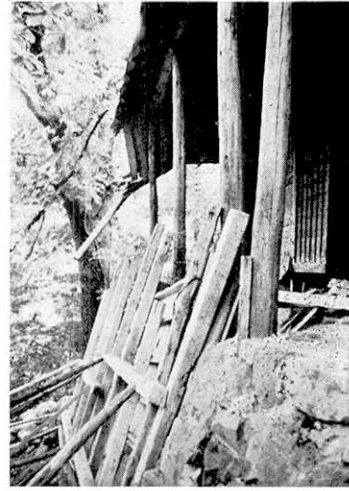
Fig. 6. ガケ崩れで家屋の一部が不同沈下し被害を生じた例. (勝原) (森本良平氏撮影)
