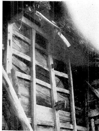
Fig. 2. 同左、柱が上の方で折れている。
