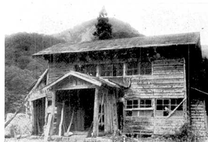
Fig. 4. 下小池の小中学校分校。内部の壁にひびわれがあつた程度で被害軽微。
