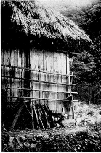
Fig. 5. 奥平小池の住家. 土台石の上で柱がずれている。
