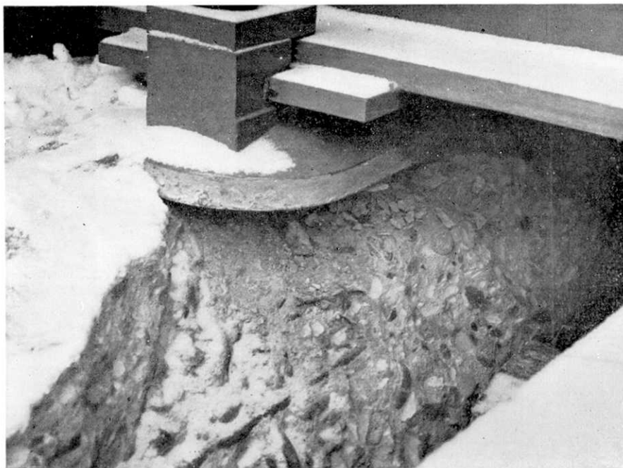
Fig 20. 弟子屈阿寒横断道路の夕映橋橋脚の破損 (北海タイムス社の提供による)
