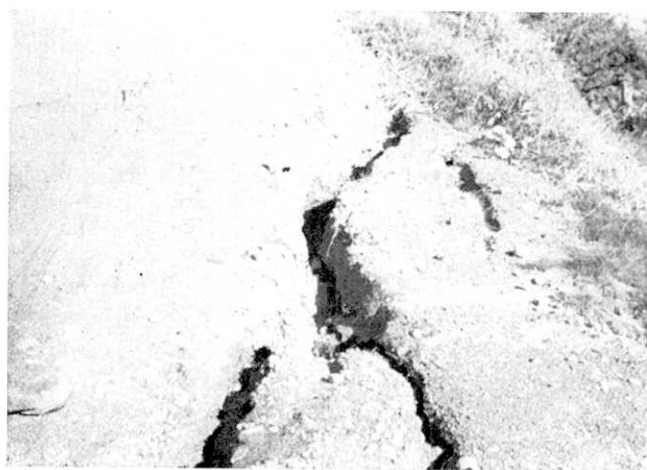
Fig. 17. 道路の地割れ (白石市南方)
