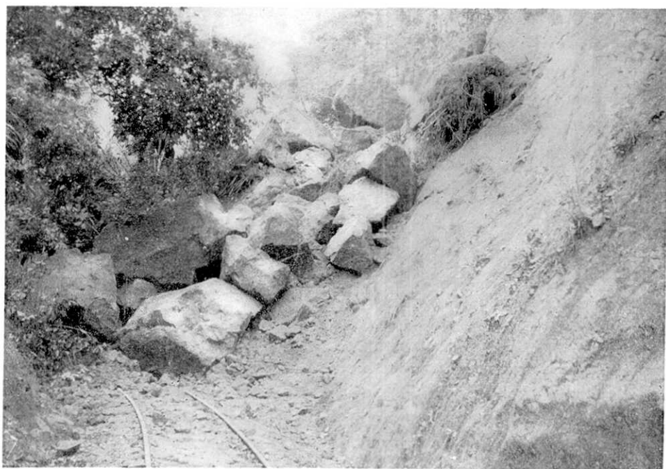
岩下落下による林用軌道の被害 (七座営林署 伊藤氏撮影)
