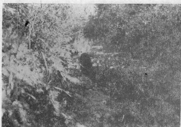
第 40 圖 矢矯, 洞各間の山地の峠附近に見る斷層地割れ
