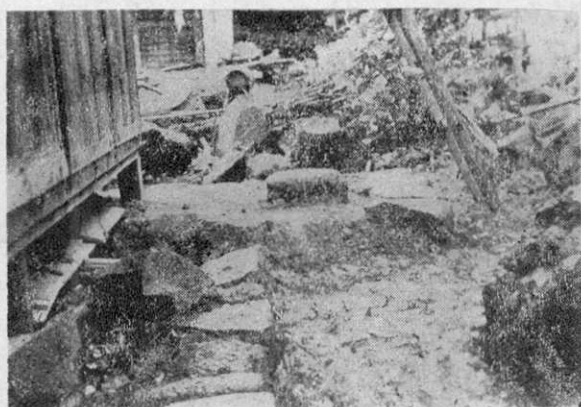
第32圖 有田氏宅(第8圖8の地点)の土臺下を通る吉岡断層
