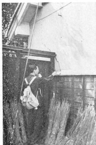
第 22 圖 赤沼東組の地割れ
