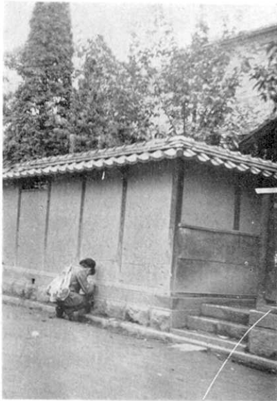
第 22 圖 土塀長さの方向(東北方)へ 9 cm 滑動(若槻村徳間)
