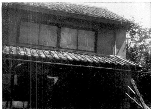
第 10 圖 吉田に於ける塗壁式構造，柱の折損
