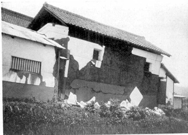
第 6 圖 吉田の壁の被害
