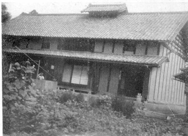
第 8 圖 古里村字富竹の住宅被害なし，七十年前の建築佐治木真知氏宅柱四寸角
