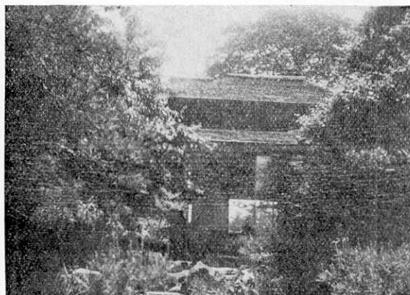
第2圖 西側より見たる地震の間
