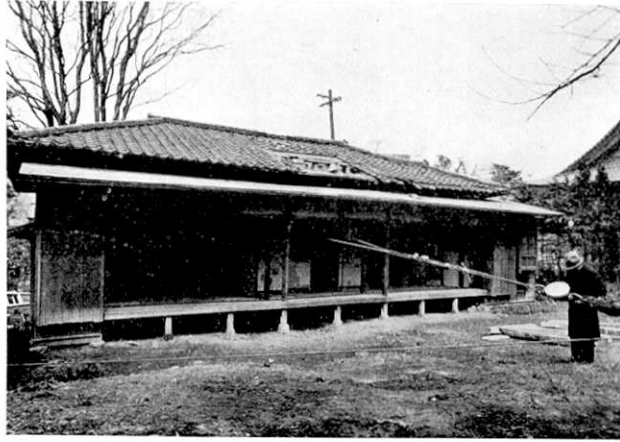
第 16 圖 加力装置と動力計取付 (正面方面のみへ加力)
