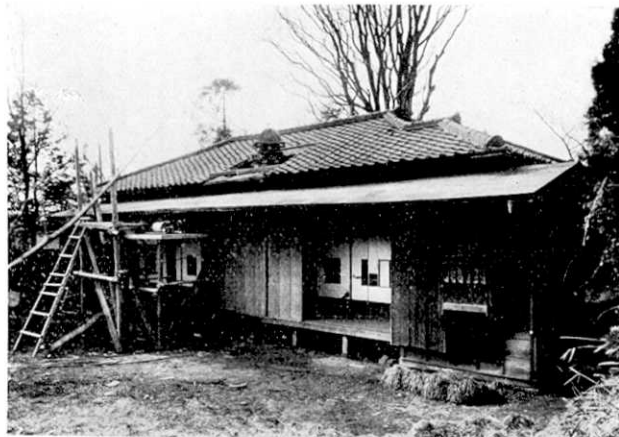
第 15 圖 振動機の取付及正面變形記録装置
