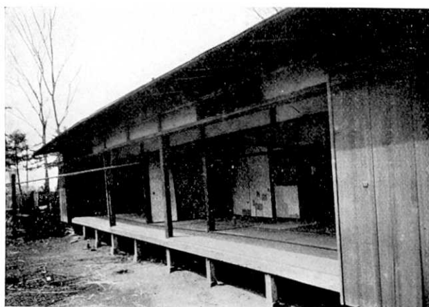
第 19 圖 斜方向加力中 (約 4 トン) 襖, 障子歪み又は破損し, 土壁龜裂剥落す
