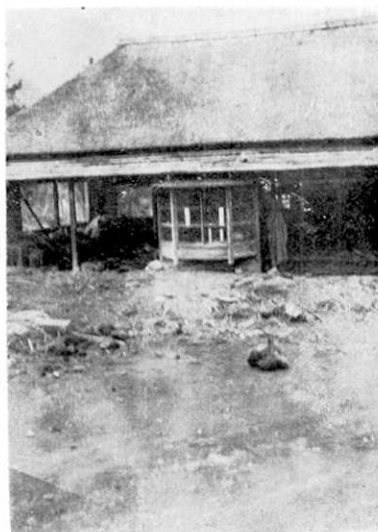
第 12 圖 b) 5 月 15 日の山津浪による家屋の被害(床上没土)
