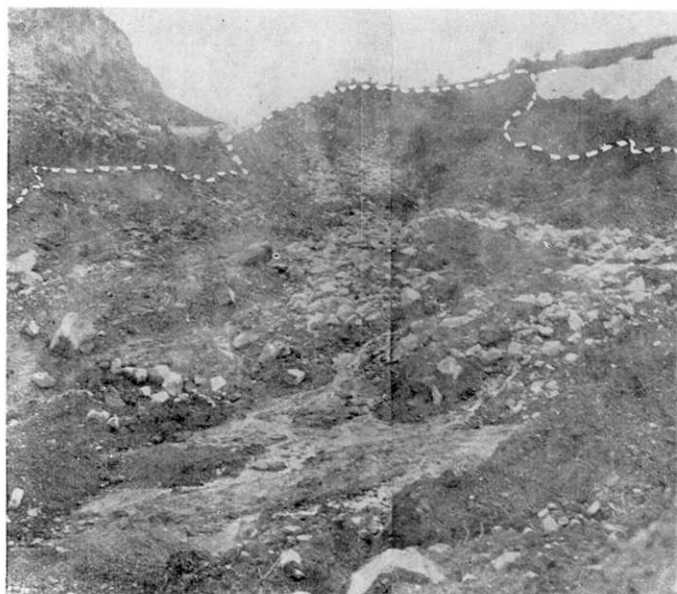
第 13 圖 b) 崩壊現場地の最上部分
