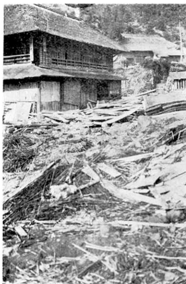
第 12 圖 a) 5 月 15 日の山津浪による家屋の被害
