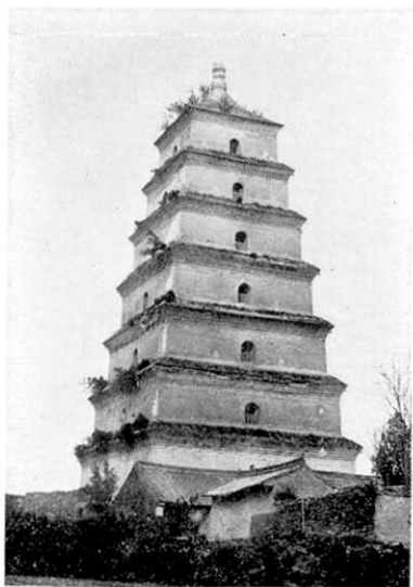
寫真第 5. 慈恩寺大雁塔 關野博士撮影 高さ 60 米と稱す
