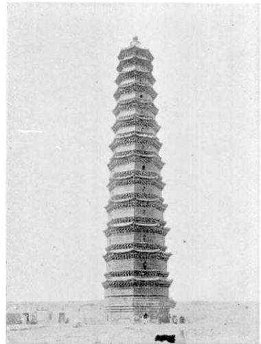
寫眞第 12. 祐國寺鐵塔 關野博士撮影 高さ 23 丈と稱す
