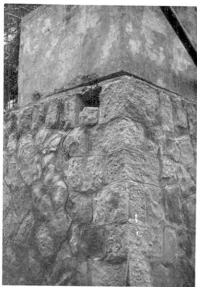
(d) 白濱湯崎温泉 白濱ホテルのコンクリート構造物 に入りたる亀裂
