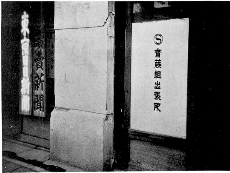
第 23 圖 静岡市内某所. 商店造り建物の外装モルタル龜裂 Siduoka city
