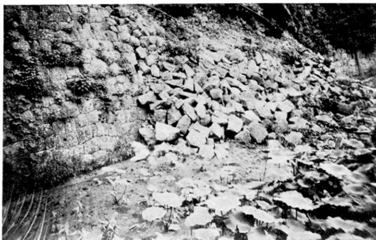
第 20 圖 静岡縣廳前壕の石屋崩壊 Siduoka city
