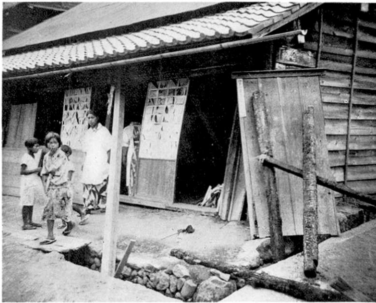
第 16 圖 静岡市大谷. 家屋の傾斜 Ooya (Siduoka)
