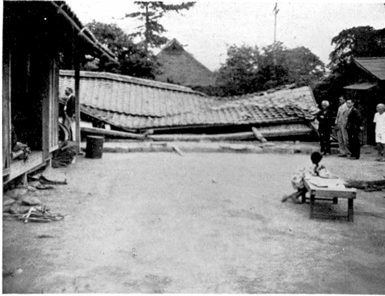
第 15 圖 静岡市大谷. 平屋建納屋の倒壊 Ooya (Siduoka)
