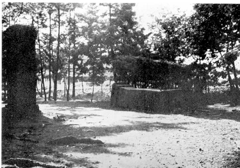
第 18 圖 池田，本覺寺煉瓦門柱の轉倒
