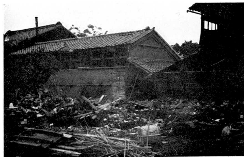
第 6 圖 西大谷, 住家の倒壊焼失
