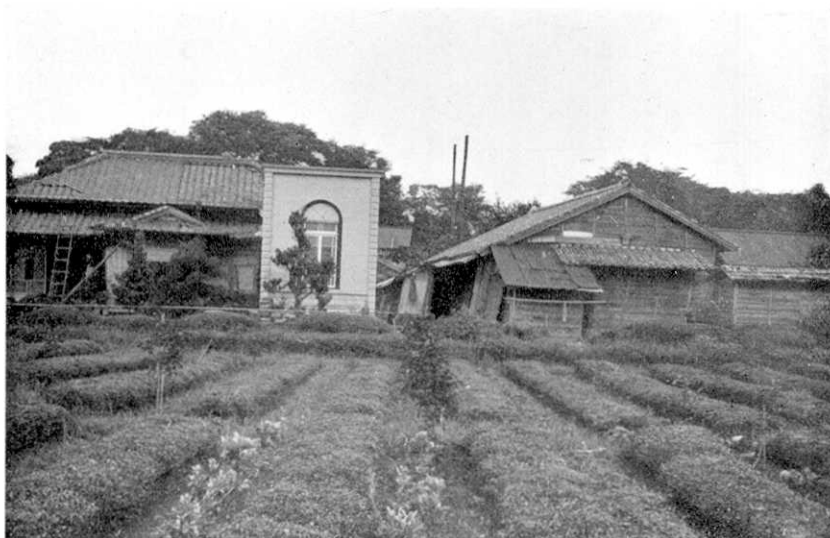
第 17 圖 小鹿，家屋は大破せるも煙突は破損せず
