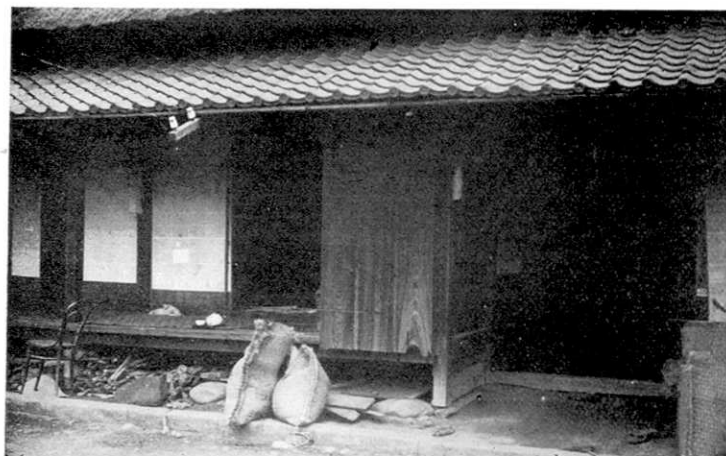
第 13 圖 宮川, 家屋の移動 (約 30 寸移動せるも障子紙も破れず建附も狂はない)
