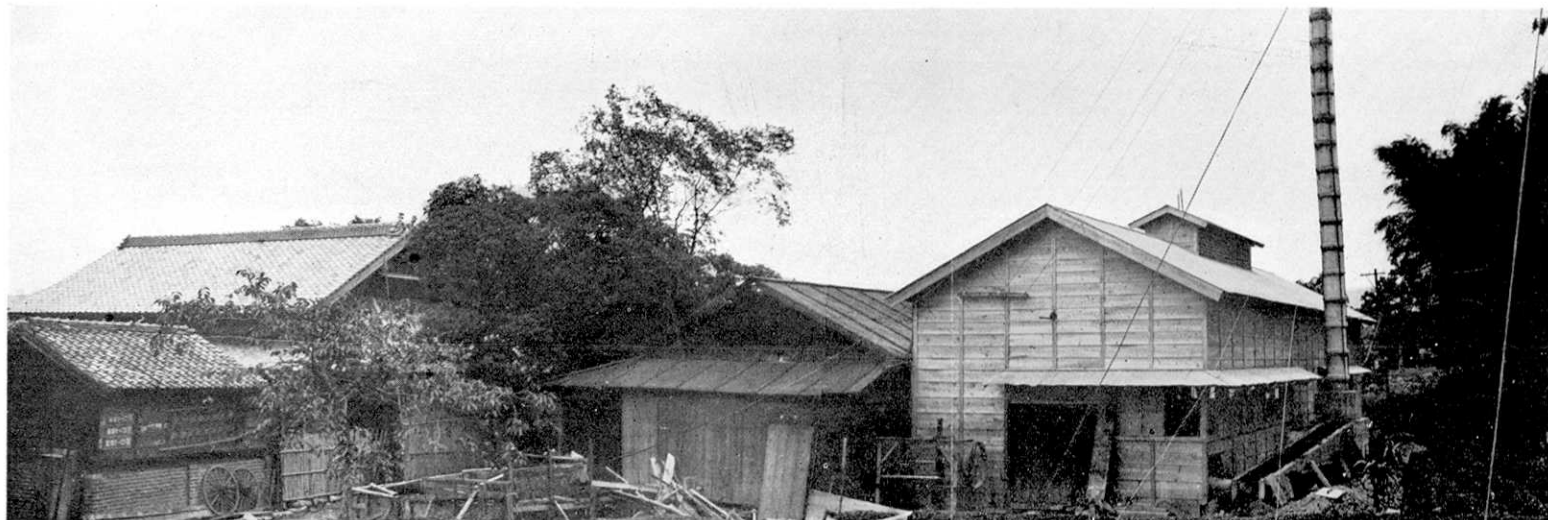
第 14 圖 片山, 寫真左手の家屋は約 30cm 移動せるも煙突には被害無し
