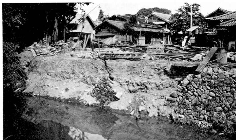
第 17 圖 静岡市高松大谷川護岸工崩壊し家屋も亦全潰す (寫眞は既に片附けを終了せるところを示す)
