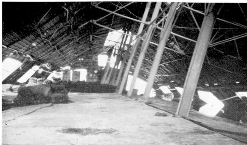
第 8 圖 清水市兩岸壁倉庫
