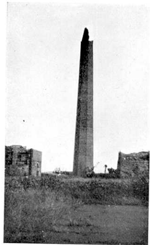
第 14 圖 中島村 煙突の破損 (高さ約 100 尺)
