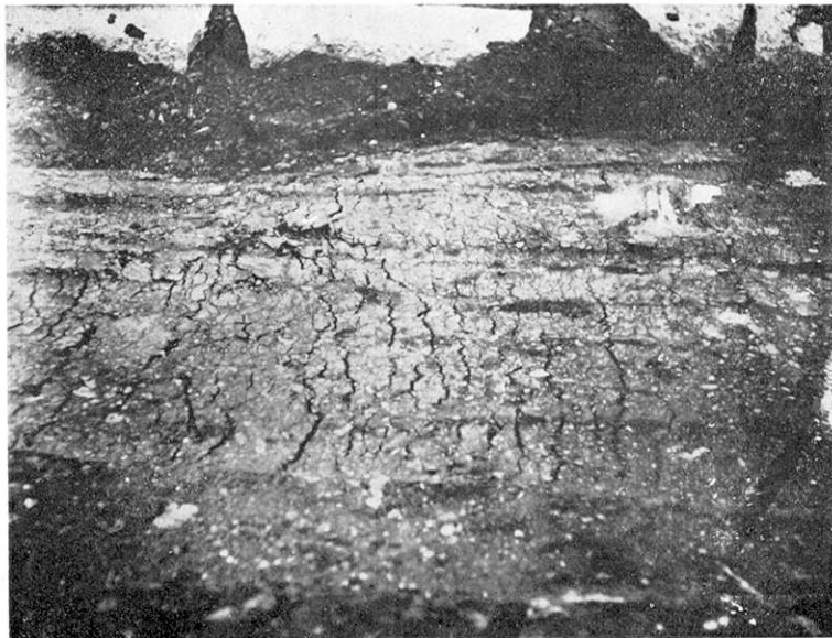
第六圖 道路工事中のローラーによつて生じた地面の平行な割目 Fig. 6. Parallel cracks due to cylindrical bending of a rough surface.
