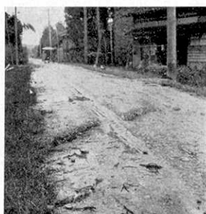
雲出縣道の段違ひ (南方 4 センチ 落ちる) Fig. 2 b
