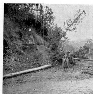
雲出臺地北端の崩壊 (ローム) Fig. 2 a
