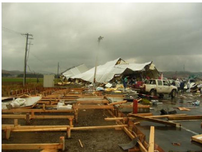
(a) 被災直後の新佐呂間トンネル作業事務所・宿舎（国土交通省北海道開発局提供）
