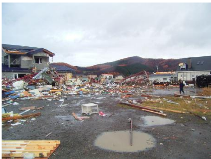
(b) 被災直後の新佐呂間トンネル作業事務所向いの状況（国土交通省北海道開発局提供）
