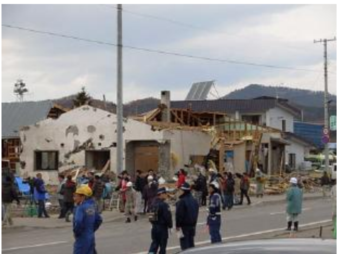
(c) 事務所併用住宅の被害
