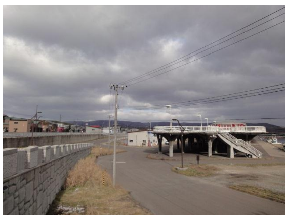
（青苗地区低地部：宅地(左側)は盛土を施し嵩上げされており、漁港（右側）との高低差がある。）
