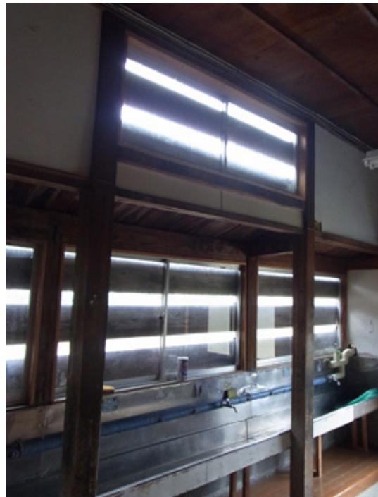
図 2.2-16 内部からみた雪囲い
