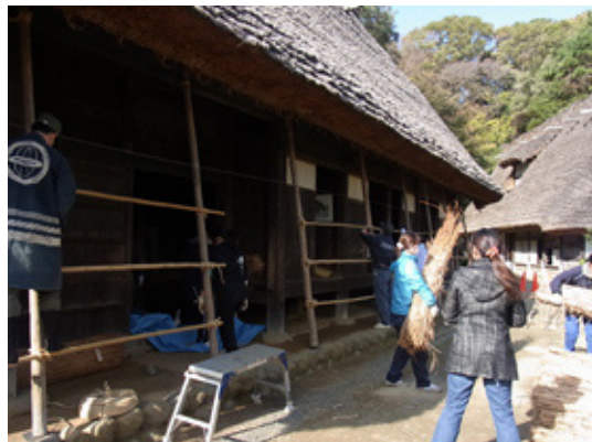
図 2.2-4 雪囲い設営の様子
