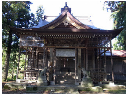
図 2.2-9 板がない状態の巢守神社の雪囲い
