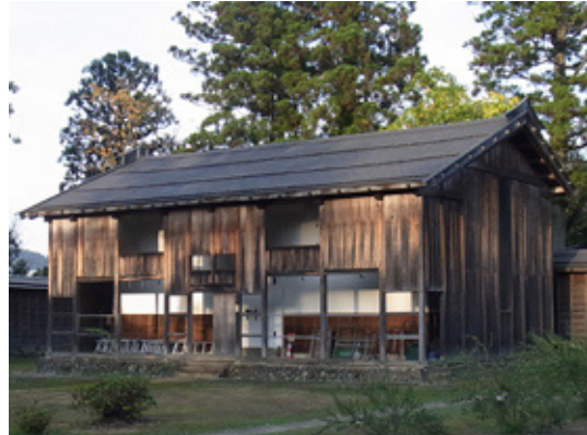
図 2.2-17 長谷川家住宅新蔵 外観
