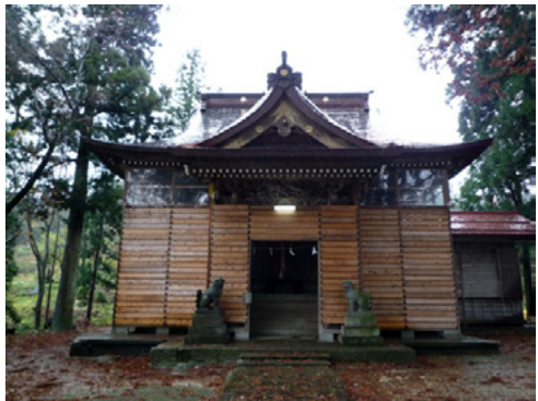
図 2.2-10 板を落とし込んだ巢守神社
