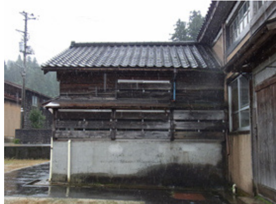
図 2.2-14 開口部の雪囲い 外観
