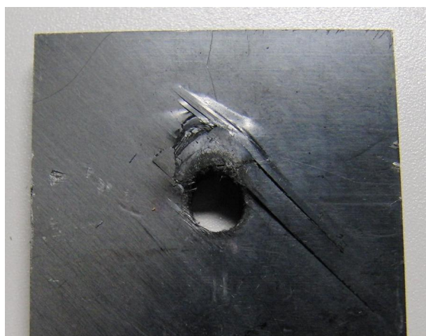
(a) 表面の損傷写真
