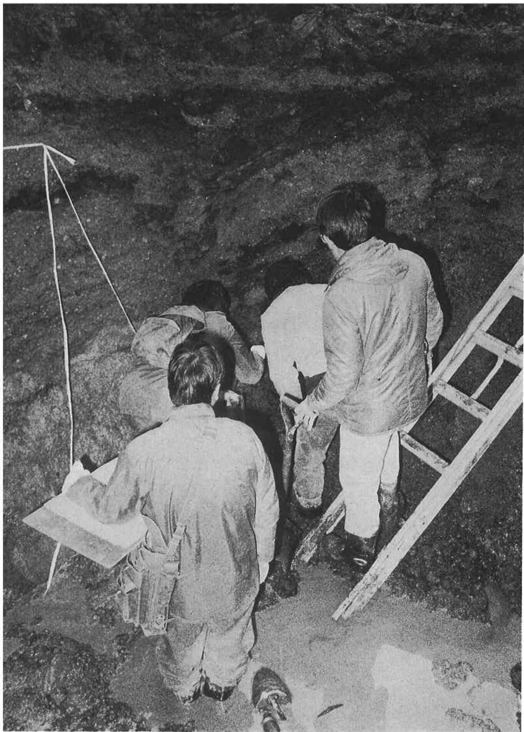
山崎断層では、先に平安時代頃の大地震の痕跡が見つかったが、もっと古い時代のことを調べるために、調査溝をもう少し深く掘り、基盤岩に達する4.5mの深さまでの地層断面を観察した。そこでは地層が大きく乱れ、少なくとも数回の大地震があったと推定される。
