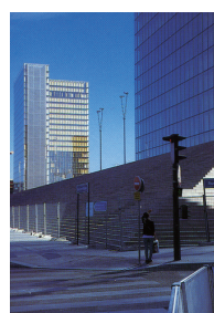
fig39 街路から見るフランス国立図書館
