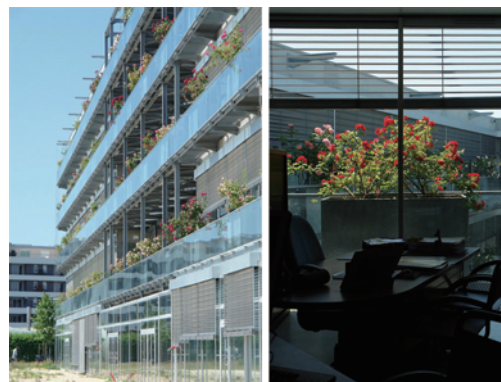
fig15 経営科学大学の外観・内観
