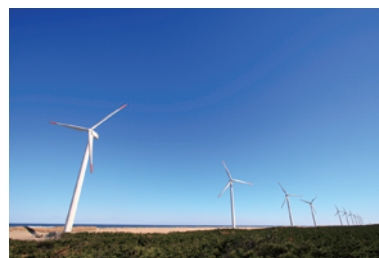
fig121 波崎風力発電所
