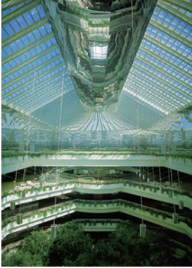
fig4 ジェネラル・フーズ本社ビル
