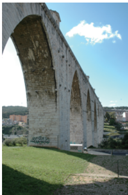
fig2 アグアス・リブレス水道橋
