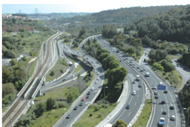
fig3 アグアス・リブレス水道橋からの風景
