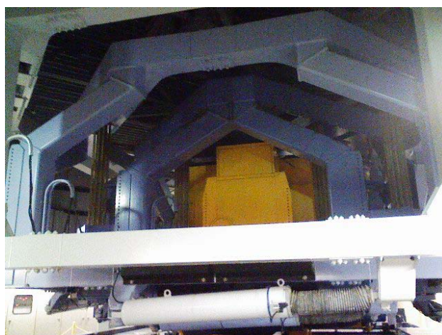
左図：台北 101 に取り付けられた TMD 右図：横浜ランドマークタワーに取り付けられた制振装置
